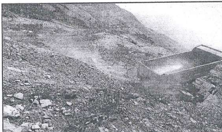
SE APRECIA LA COLOCACIÓN Y TENDIDO DEL MATERIAL GRANULAR DE CANTERA EN EL KM 3+000
