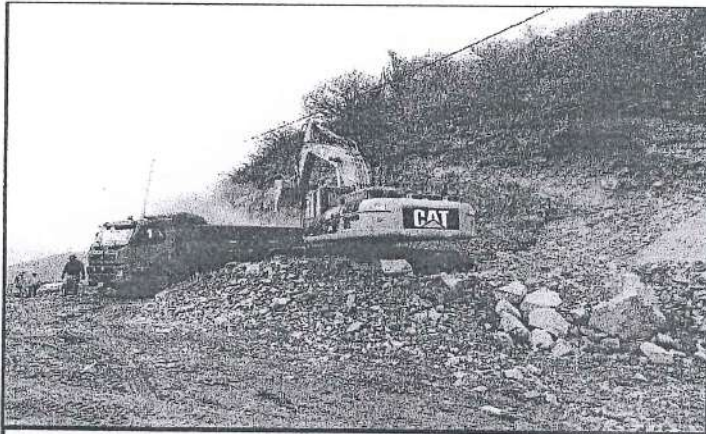
SE APRECIA LA EXTRACCIÓN Y TRANSPORTE DEL MATERIAL GRANULAR DE LA CANTERA N° 01
