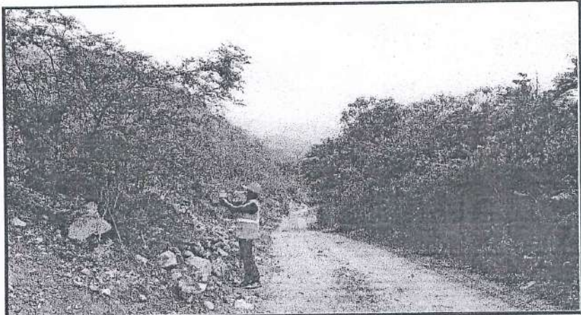
SE OBSERVA LOS TRABAJOS DE LIMPIEZA GENERAL ROCE Y DESBROCE EN EL Km 1+800
