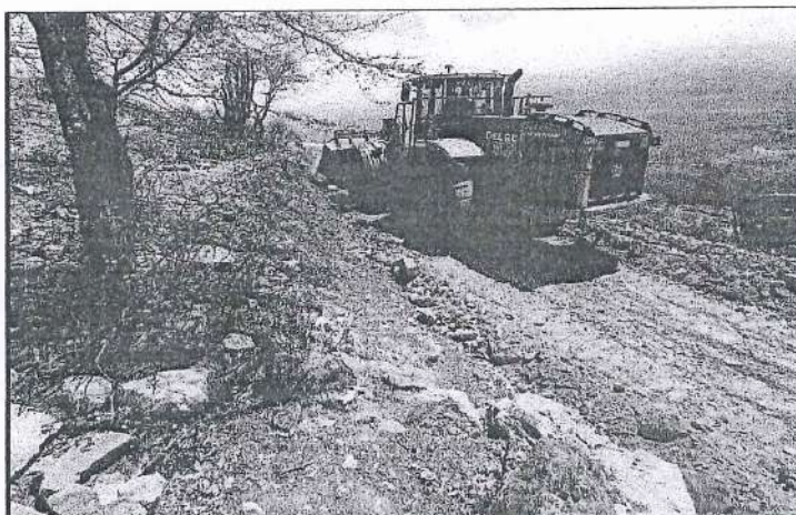
SE APRECIA EL TENDIDO DEL MATERIAL GRANULAR EN EL 3+400 KM
